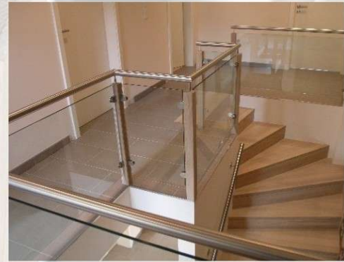
Stufen auf Beton
